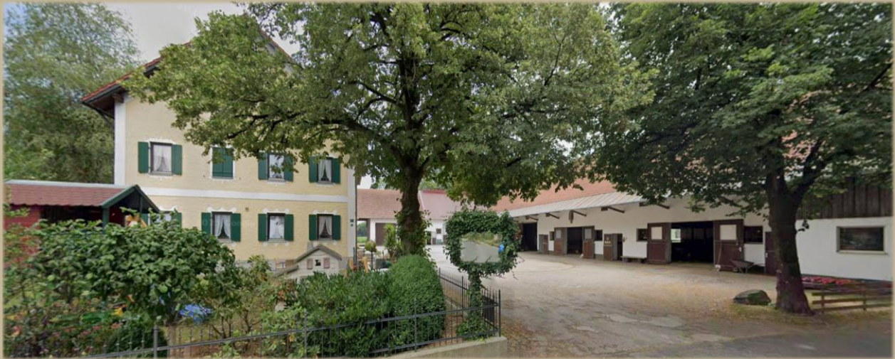
Quelle: Google Street View Juli 2023 ~ Hörbach, Luttenwanger Straße 13
