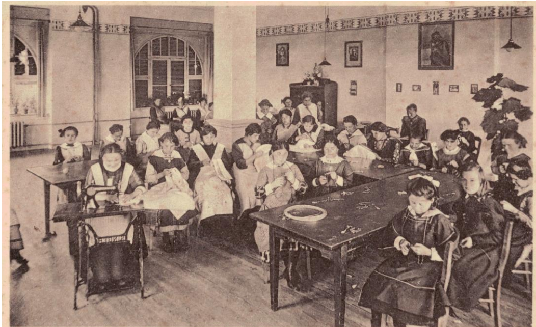
Magnusheim Holzhausen. Arbeitsaal
