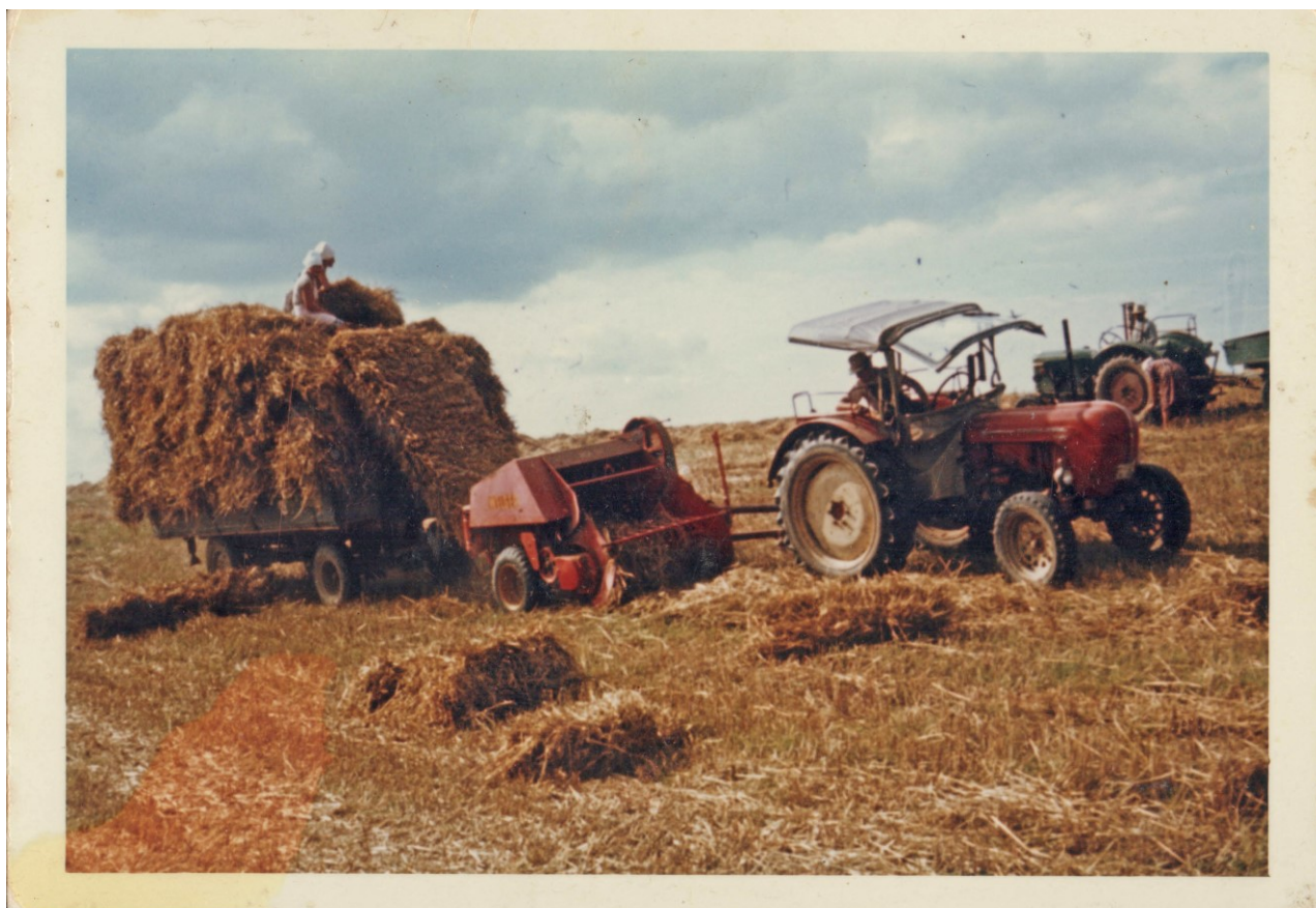
Aus dem Familienalbum der Familie Erhard, Sirchenried, Aufnahme ca. 1965 Strohernte mit dem Porsche Diesel Super, Bj. 1960, 38 PS und Welger-Hochdruckpresse
